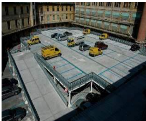
Struttura multipiano nell'ex Manifattura
